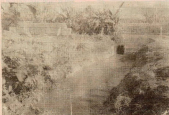
El mantenimiento de los canales de regadío se hace eficientemente.
